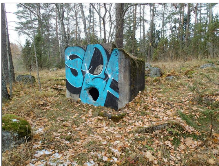
Laen länsipäässä oleva betonirakenne
