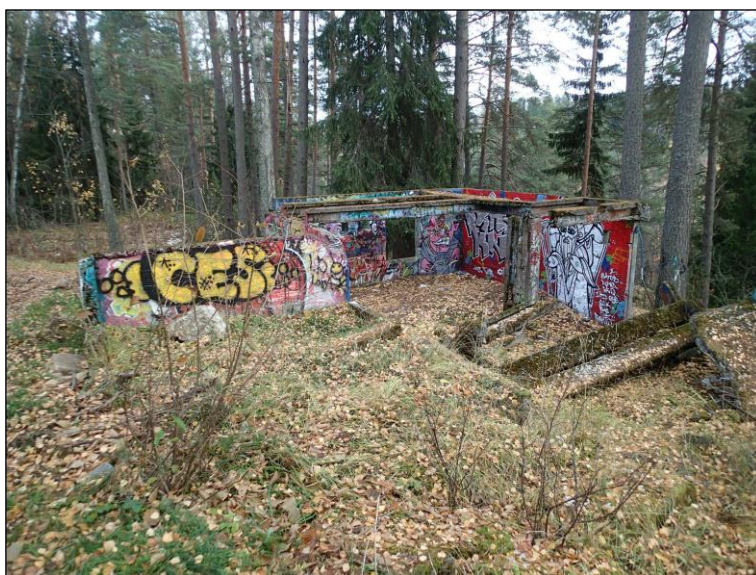
Laella olevan betonirakennuksen jäänteet.
