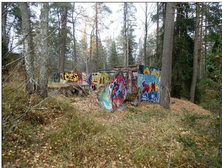
Laella olevan betonirakennuksen jäänteet.
